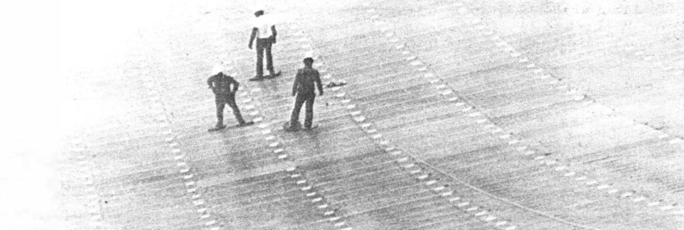
På stor fot lever de som har till uppgift att kontrollera den nya aluminiumbegränsningen. På det här sättet skyddar man de ömtåliga plåtarna och fördelar tyngden över en större yta.
